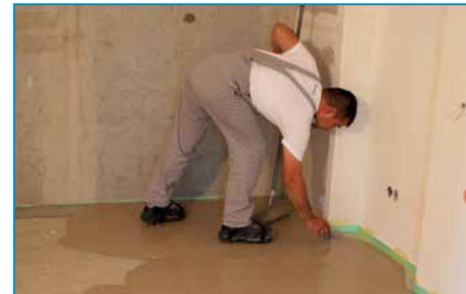
Az anyag terülését a sarkoknál simítóval vagy kőműveskanállal segítjük.
