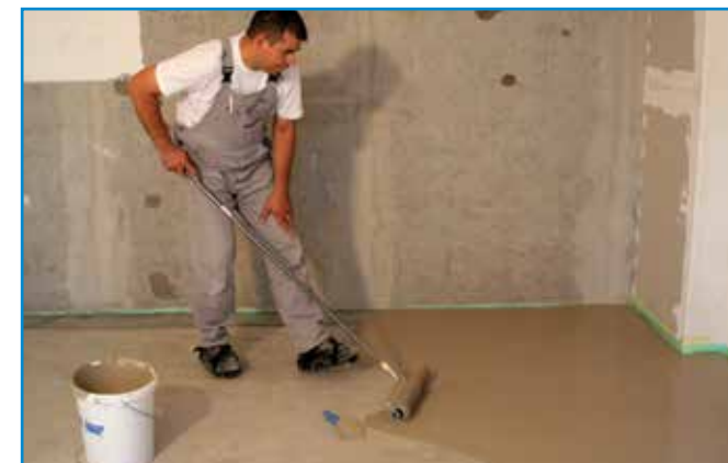
A homogénre kevert aljzatkiegyenlítőt vödörből végzett terítéssel hordjuk fel a megfelelően előkészített aljzatra.
